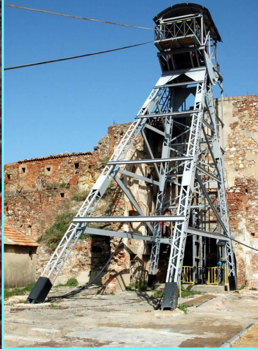
Pozo de acceso.
